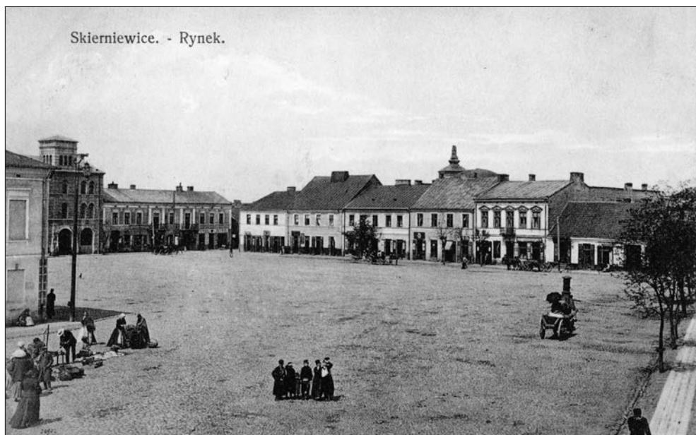
Fot. 3. Widok rynku z roku 1905. Adres ul. Rynek 30 to parterowy budynek pierwszy od lewej strony, widoczne drzwi wejściowe do restauracji.
